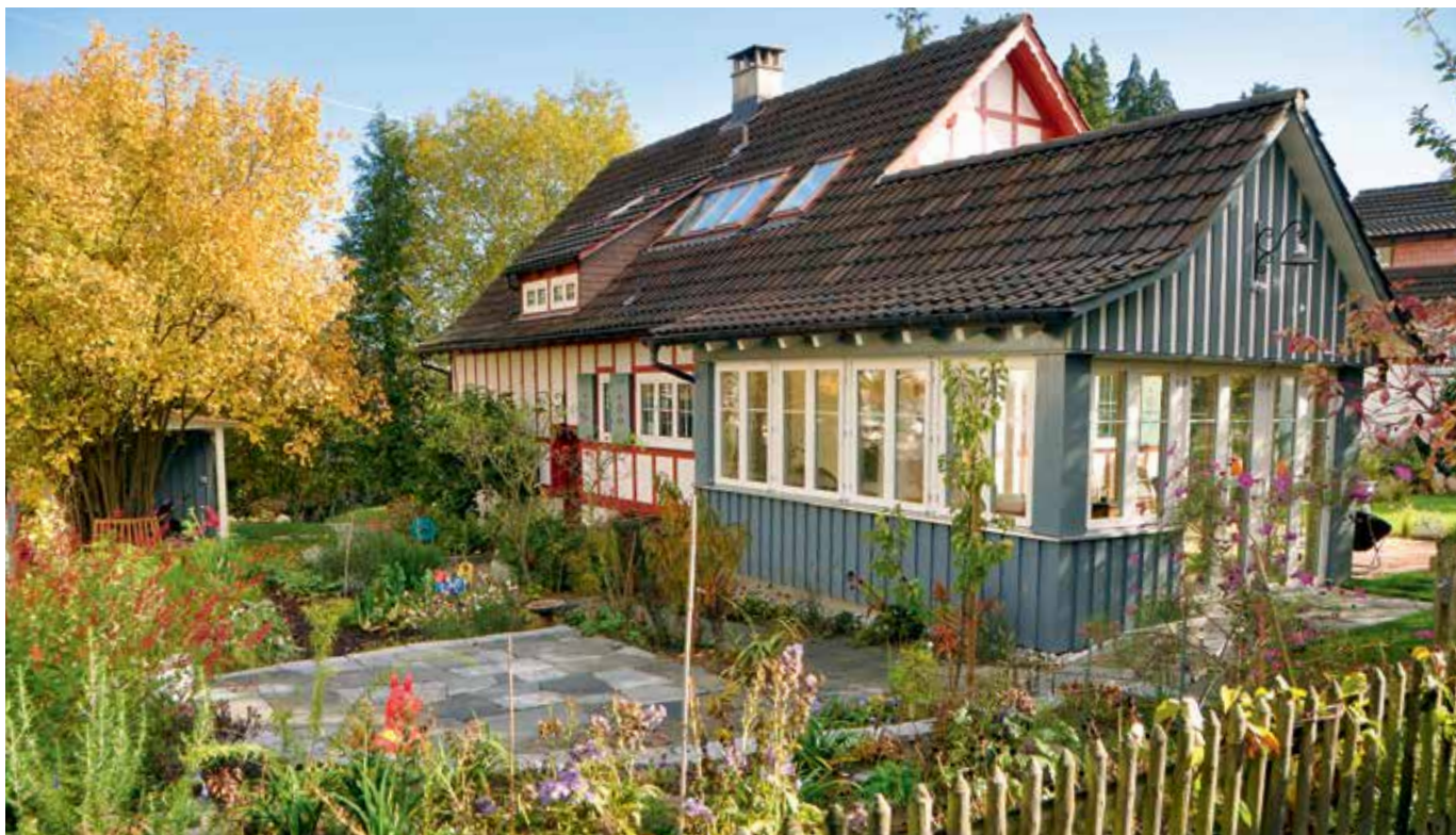
Auf dem leicht abschüssigen, verbuschten Terrain entstand ein schön abgestufter Aussenraum.
